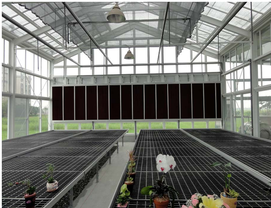
圖二、自動化澆灌系統及電動遮陽簾
